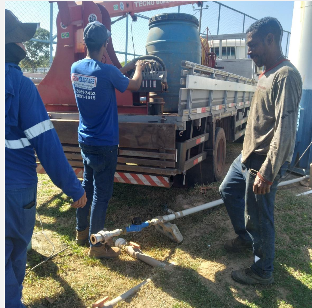
Troca da bomba e limpeza no poço artesiano
