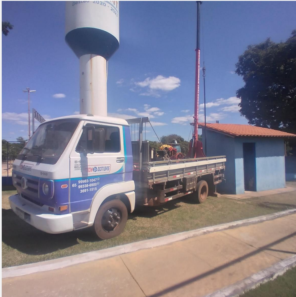
Troca da bomba e limpeza no poço artesiano
