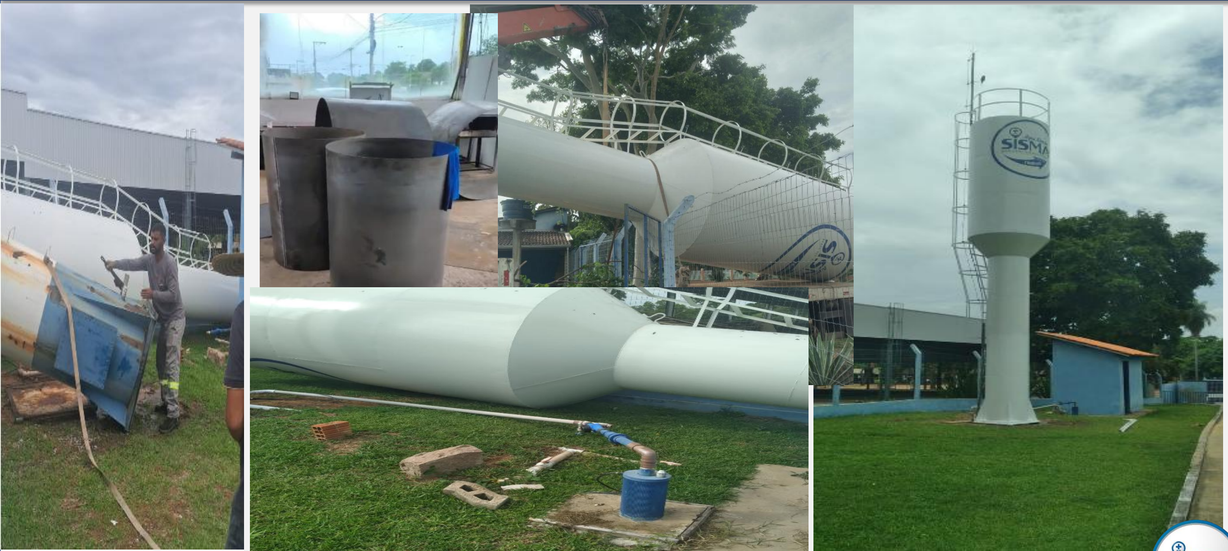
Troca da taça e limpeza poço artesiano
